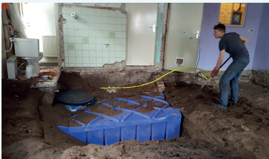
■ Op de foto mijn zoon Sjoerd in actie bij het ingraven van de hemelwatertank.
